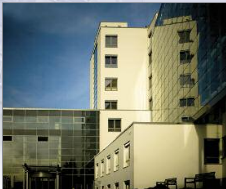
Das Haus von außen mit neuer Glasfassade
