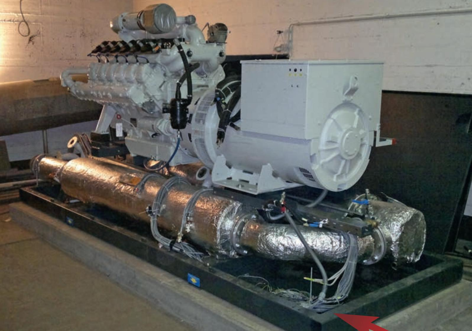
es nutzt die bei der Stromerzeugung entstehende Abwärme für die Heizung und Warmwasserbereitung.“ Zum Vergleich: Der durchschnittliche Wirkungsgrad eines konventionellen Kraftwerks liegt bei circa 38 Prozent, über 60 Prozent der eingesetzten Energie wird in der Regel als Abwärme ungenutzt an die Umwelt abgegeben. Darüber hinaus ist das Abgas des gasbetriebenen BHKWs besonders sauber, da es über einen 3-Wege-Katalysator gereinigt wird.
